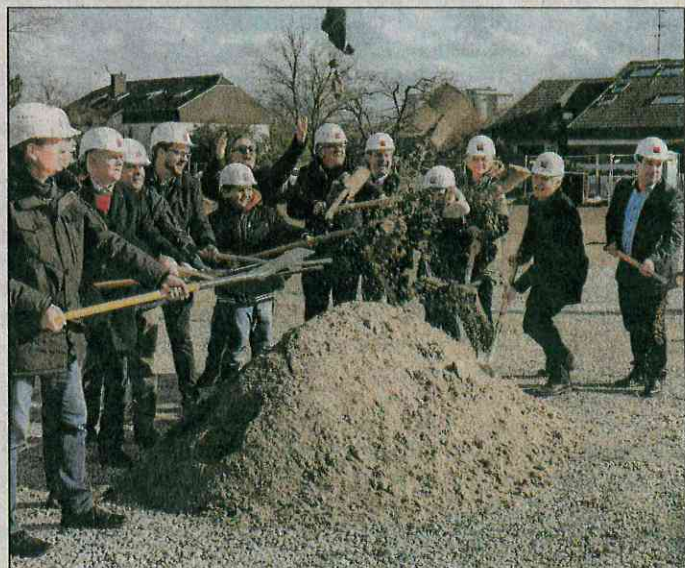
Fast wie im Sandkasten: Symbolischer Spatenstich für die Hans-Thoma-Schule.
